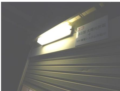
蛍光灯20型の防水ライトを改造した照明器具
